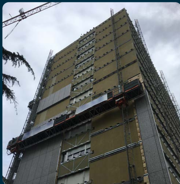
Foto 2: Un cantiere Energiesprong realizzato con ponteggi mobili. Credits: Manni Isopan
