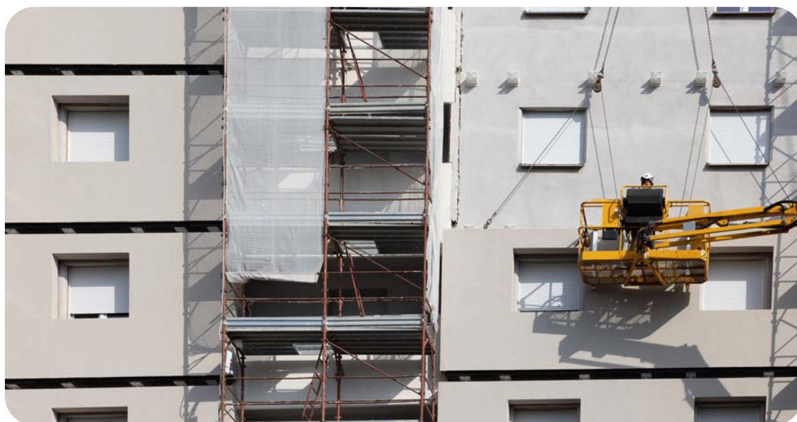
Foto 3: L'installazione in completa sicurezza nel cantiere Energiesprong di Via Russoli a Milano (Credits: Ricehouse, Beatrice Arenella)
