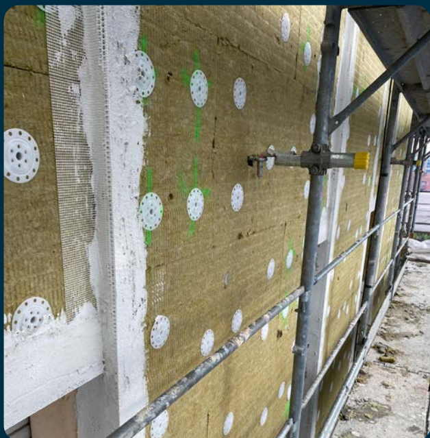
Foto 1: Posa di un isolamento a cappotto tradizionale Credits: Teicos
